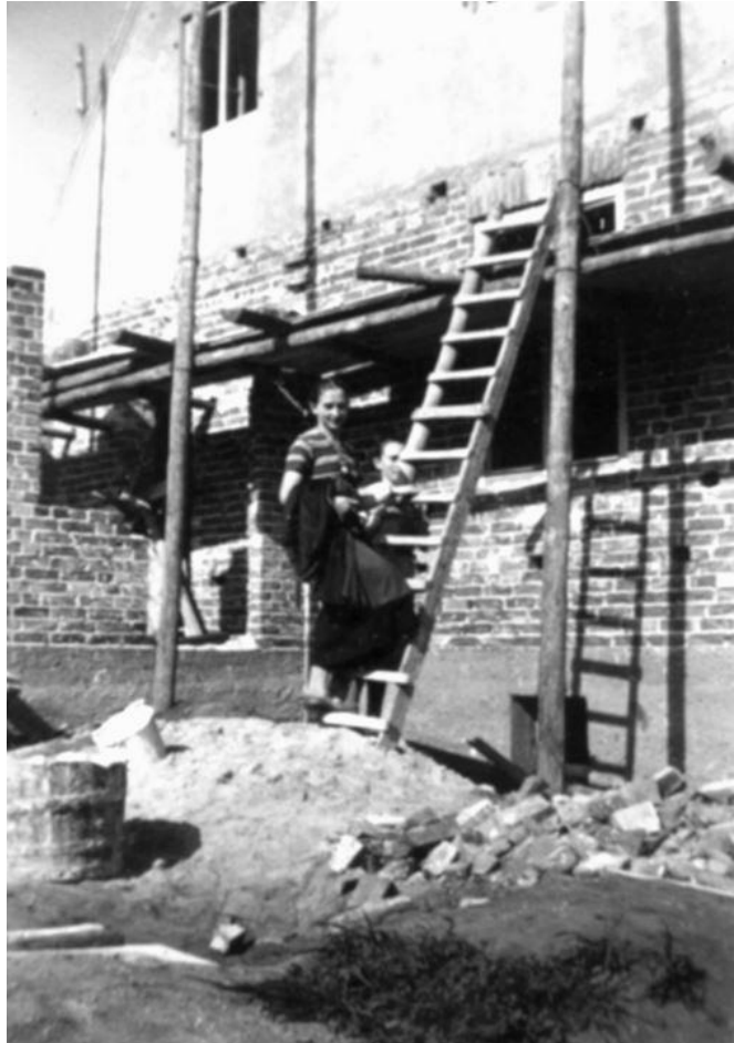
Maria auf der Baustelle Blücherplatz 15 – 1936
